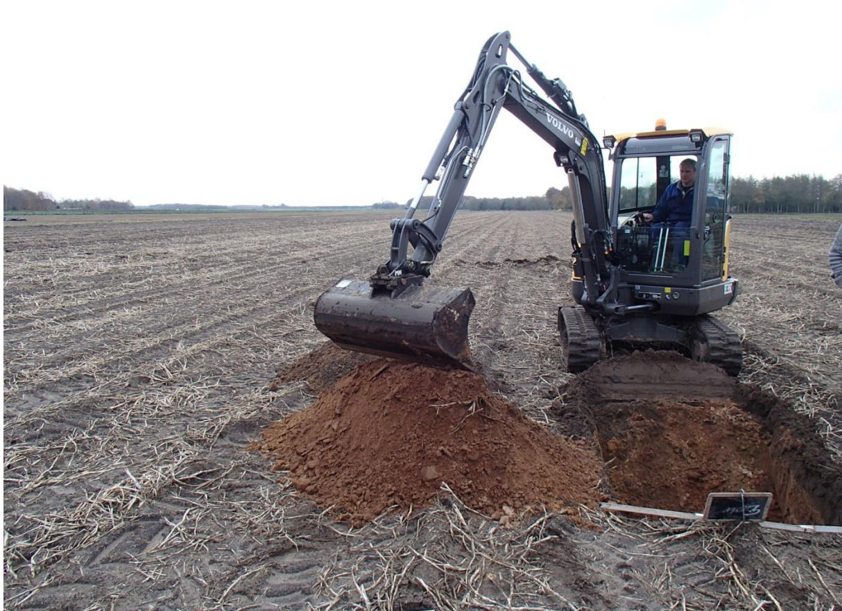
Afb. 3. Het graven van de proefputten gebeurde met hulp van een minigraver.
